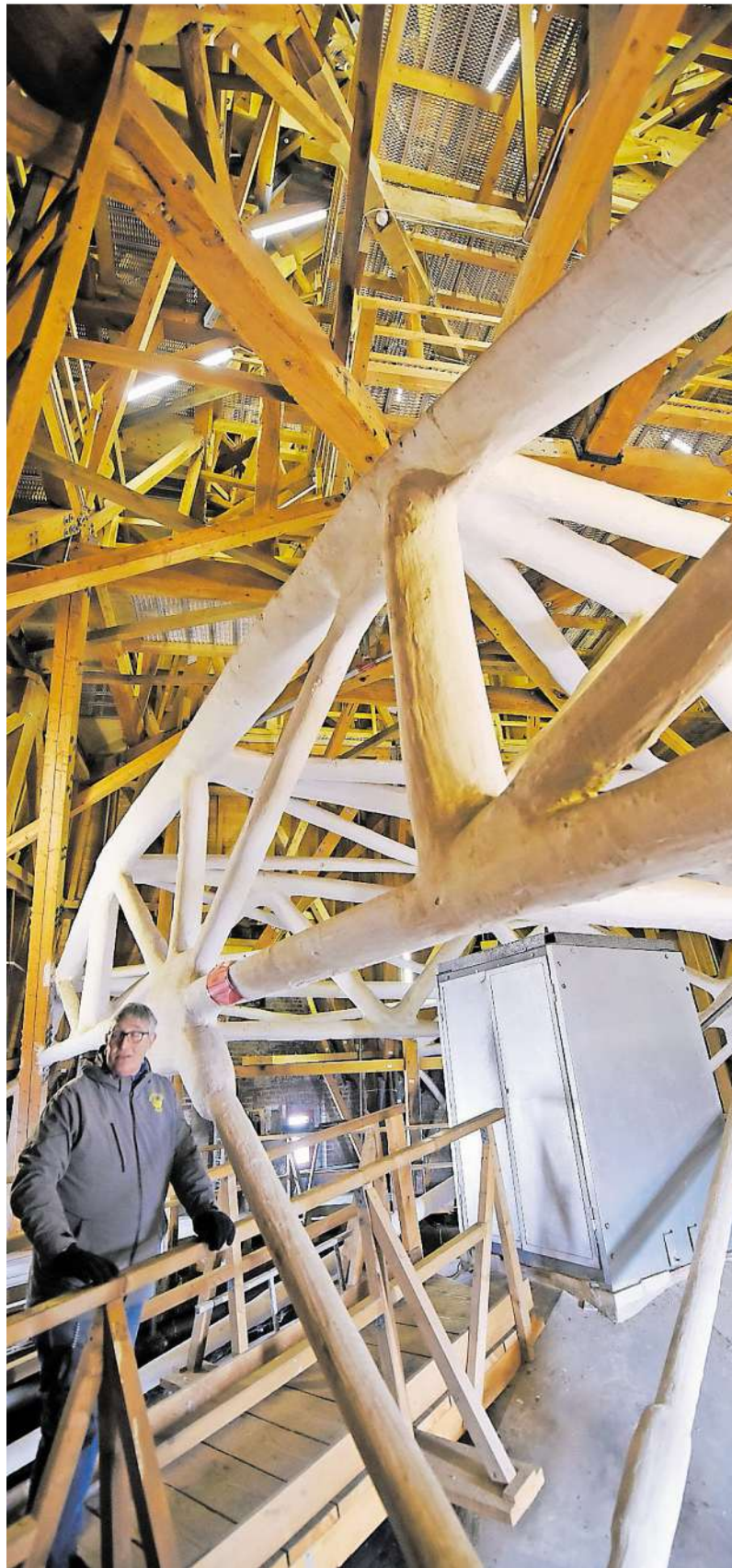
Viel zu tun: Dombaumeister Helmut Maintz im hölzernen Dachstuhl des Aachener Münsters.
