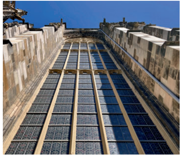
Im Juni rücken die Gerüste an: Chorfenster werden geprüft.
