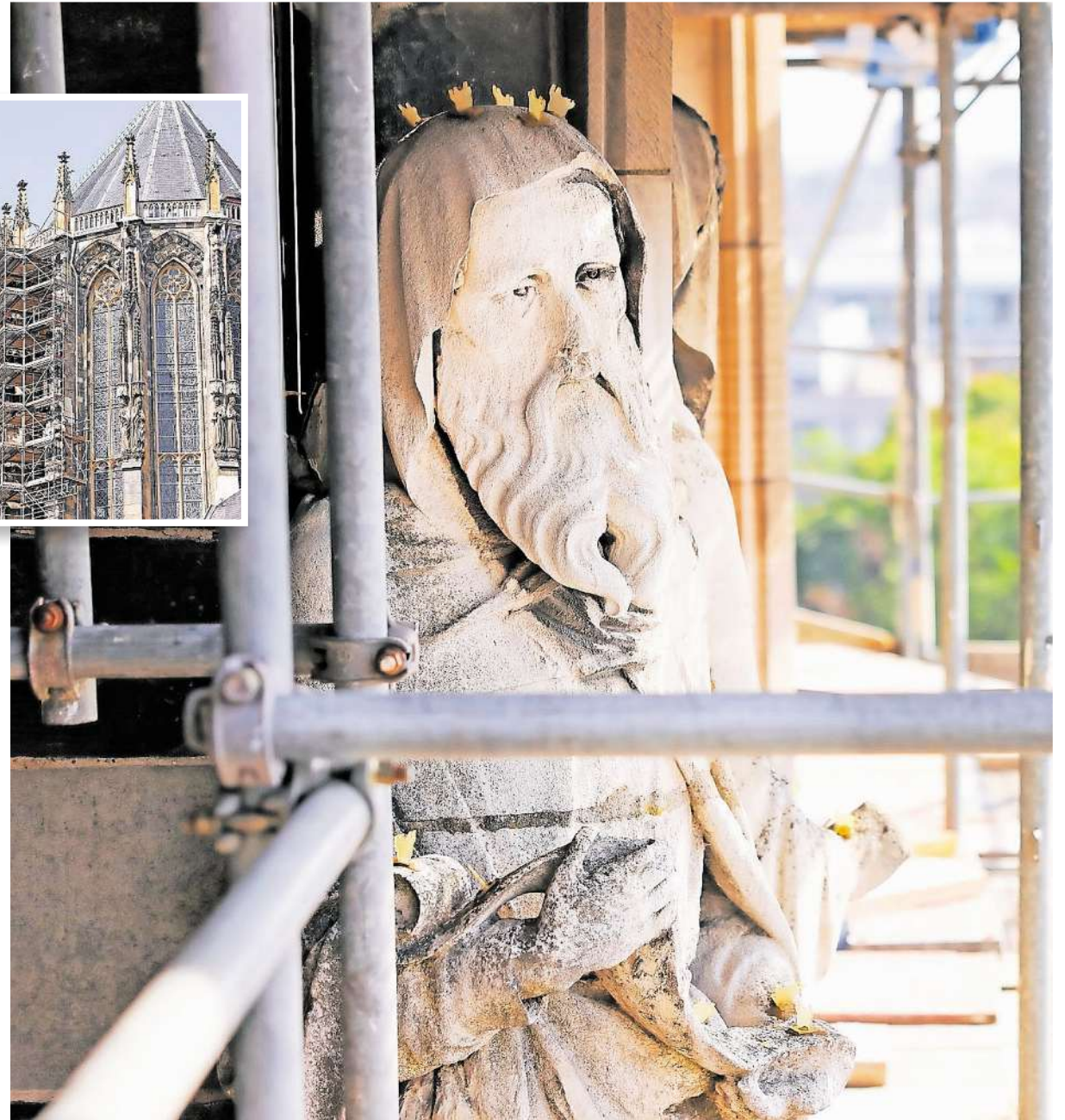
Wind und Wetter setzen dem Aachener Dom zu: Im Rahmen der Sanierungsarbeiten an der Chorchalle werden auch die Figuren an der Fassade von Expertenhand gesäubert. An der Chorchalle des Münsters (kl. Foto) müssen unter anderem Fugen und Steine ausgetauscht werden. FOTOS: ANDREAS STEINDL
